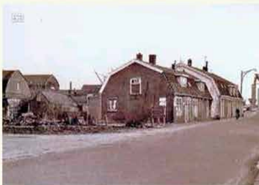
Een rijtje woningen en (net niet zichtbaar) café Ceres aan de Meerlaan bij de Hillegommerbrug, gesloopt eind jaren zeventig (01)
