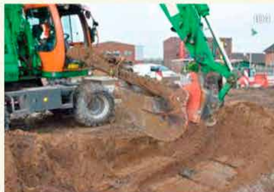
Opgegraven bielzen van de voormalige tramlijn aan de Leidsestraat (01)
