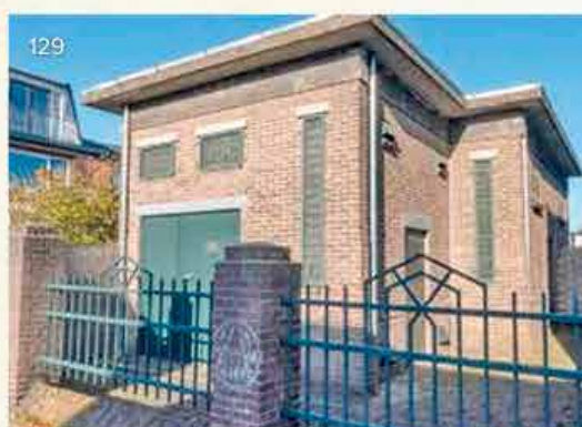
Het transformatorstation aan de Hofstraat is een gemeentelijk monument (03)
