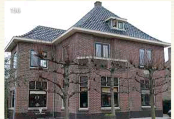
Woonhuis De Alster, Stationsweg 169, winnaar 2010 (01)
