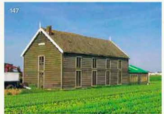
De inmiddels door een replica vervangen groene houten bollenschuur "De Hartebaan" aan de Leidsestraat (01)
