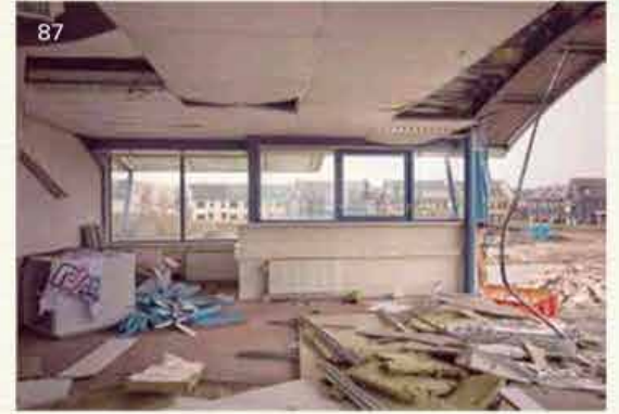
De sloop van het kantoor van de betonfabriek De Ringvaart met zicht op de nieuwe woningen van de Ringoevers (05)
