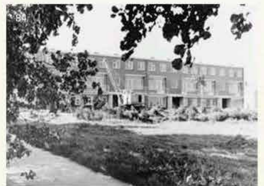
De flats in aanbouw aan de Sportlaan vlakbij de Haven (nu tegenover de bibliotheek) (01)
