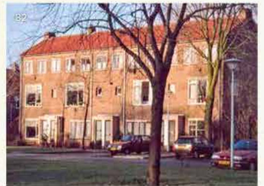
De flats aan het Oranje Nassaplein, inmiddels vervangen door de appartementen van plan Bakkum (09)
